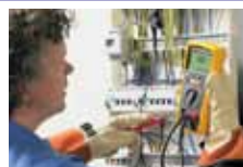
Проверка сопротивления изоляции в распределительном щите
